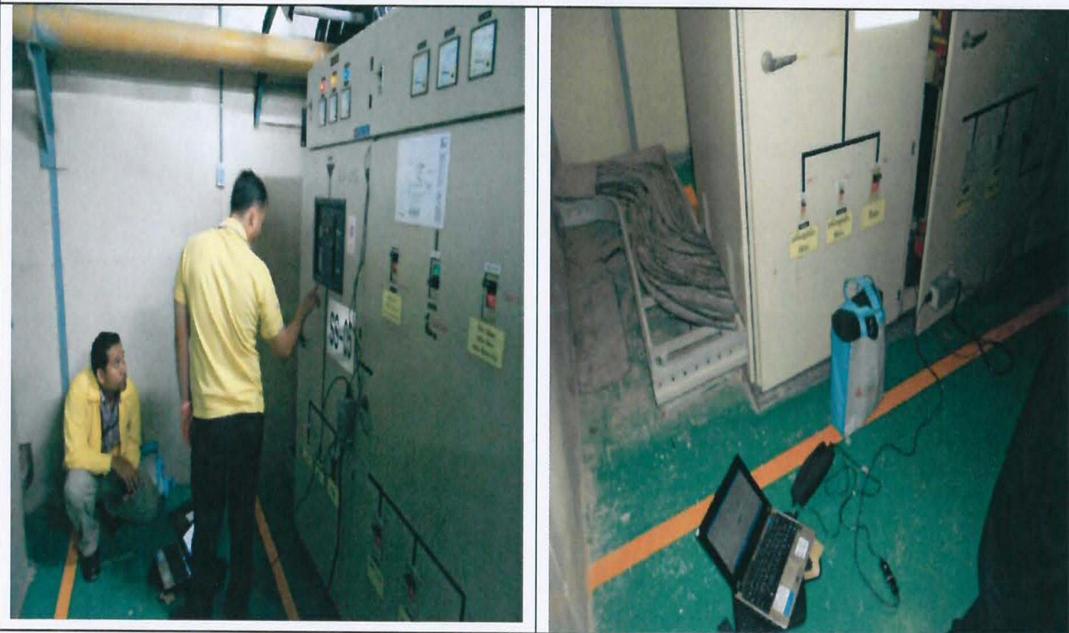
การติดตั้ง Data logger
