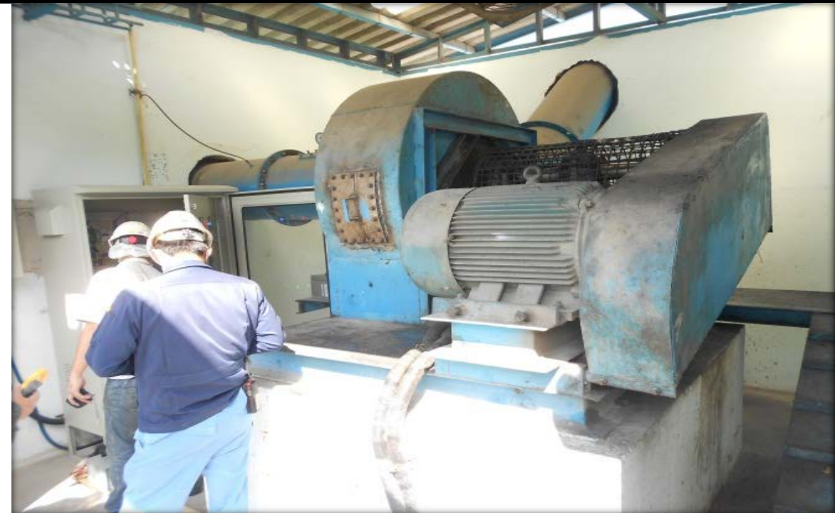
Motor Exhaust Fan
