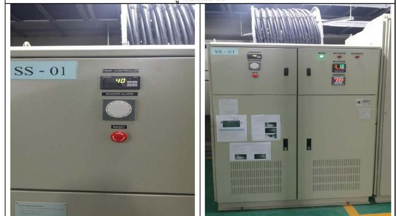
อุปกรณ์ปรับระดับแรงดันไฟฟ้าขนาด 1,500 kVA
