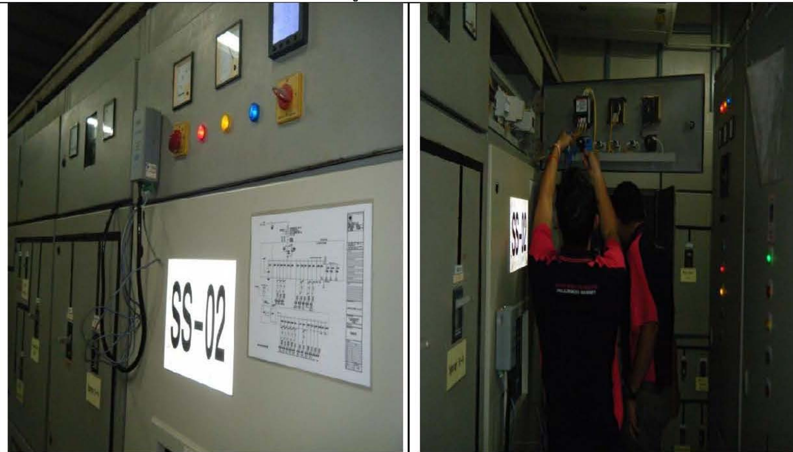
การติดตั้ง Data logger
