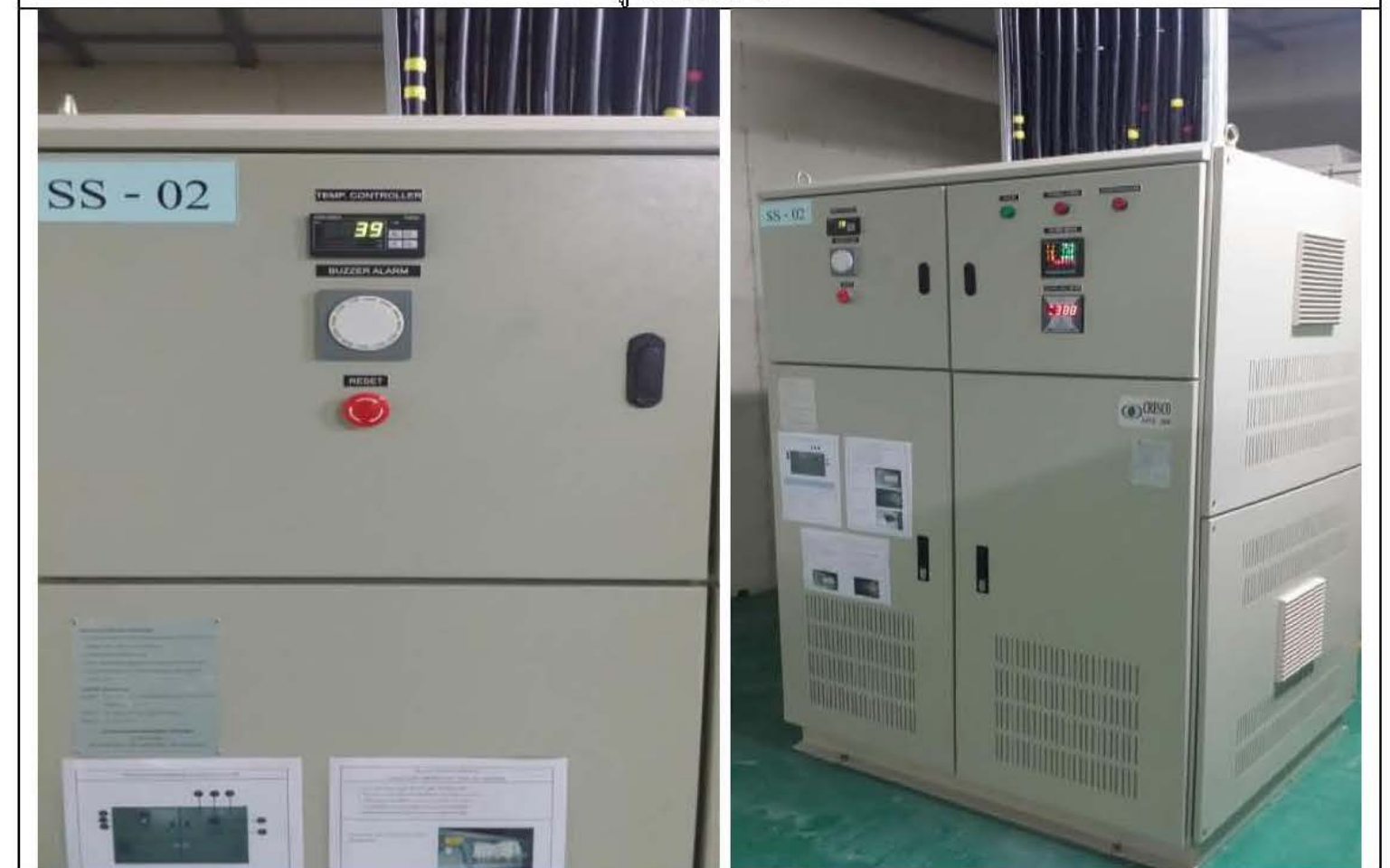
อุปกรณ์ปรับระดับแรงดันไฟฟ้าขนาด 1,500 kVA
