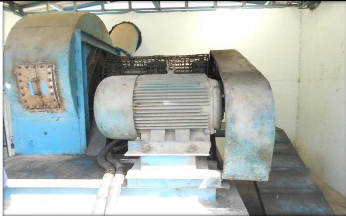
Motor Exhaust Fan
