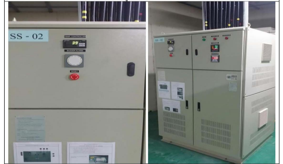
อุปกรณ์ปรับระดับแรงดันไฟฟ้าขนาด 1,500 kVA
