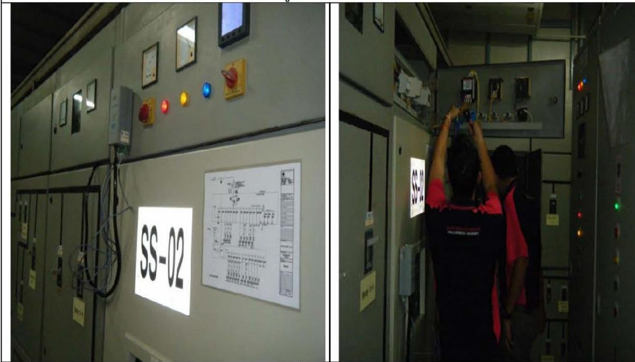
การติดตั้ง Data logger
