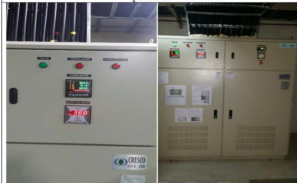
อุปกรณ์ปรับระดับแรงดันไฟฟ้าขนาด 2,000 KVA
