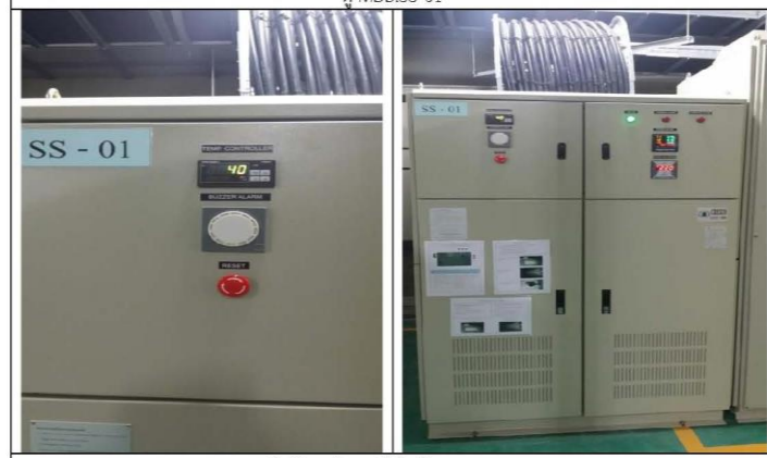
อุปกรณ์ปรับระดับแรงดันไฟฟ้าขนาด 1,500 kVA
