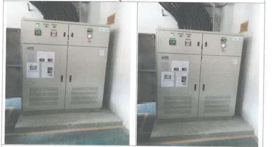
อุปกรณ์ปรับระดับแรงดันไฟฟ้าขนาด 2,000 KVA
