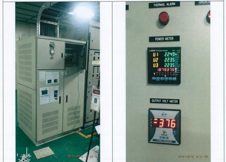
อุปกรณ์ปรับระดับแรงดันไฟฟ้าขนาด 1000 KVA
