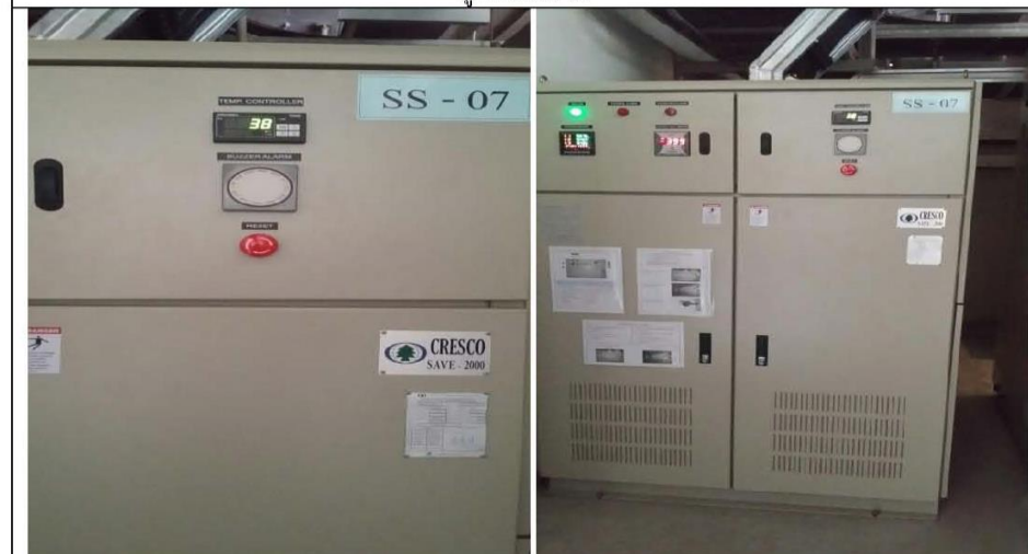
อุปกรณ์ปรับระดับแรงดันไฟฟ้าขนาด 1,250 KVA
