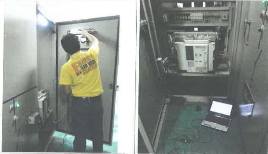
การติดตั้ง Data logger
