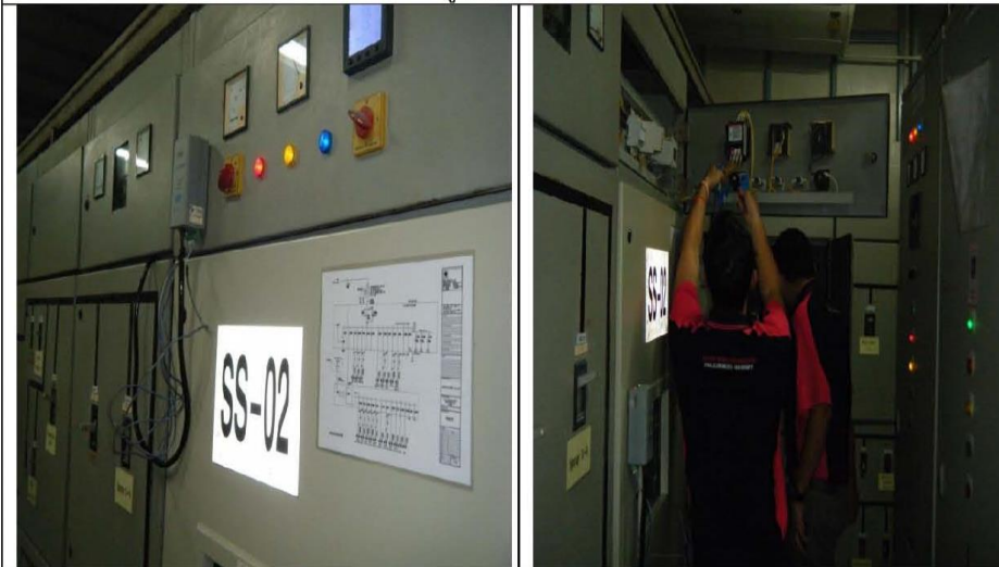
การติดตั้ง Data logger
