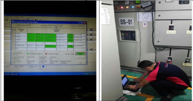
การติดตั้ง Data logger
