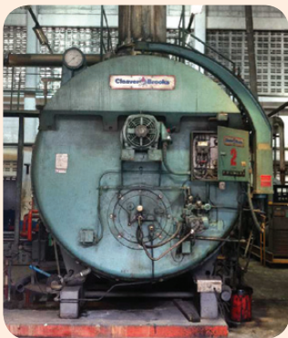
รูปที่ 10 หม้อไอน้ำความดันต่ำ โดยใช้ใช้น้ำมันเตา
