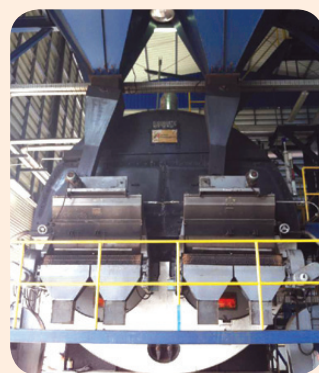
รูปที่ 11 หม้อต้มไอน้ำความดันต่ำ โดยใช้ถ่านหิน
