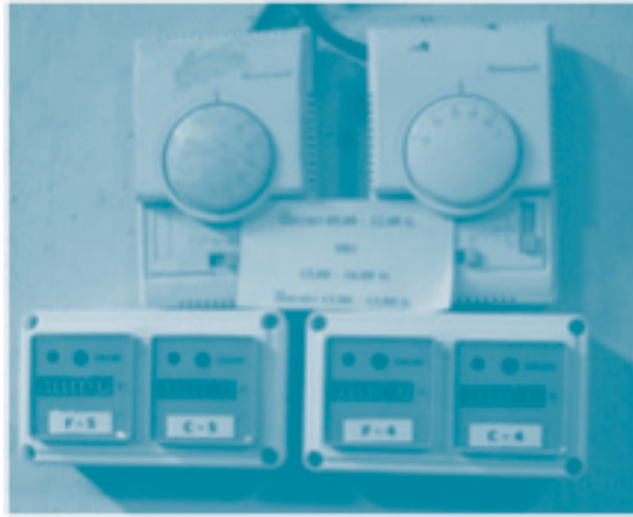
รูปที่ 4.2-2 เครื่องนับชั่วโมงทำงานของเครื่องปรับอากาศ
