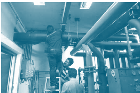
ตำแหน่งติดตั้งเครื่องมือตรวจวัดอัตราการไหลของน้ำแบบ Ultrasonic
