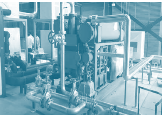
ระบบท่อน้ำระบายความร้อนให้เครื่องทำน้ำเย็นแบบดูดซึมและการวัดอัตราการไหลของน้ำเย็น
