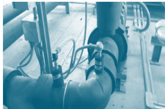
ตำแหน่งตรวจวัดอุณหภูมิน้ำเย็นด้านจ่าย(CHS) และด้านกลับ (CHR)
