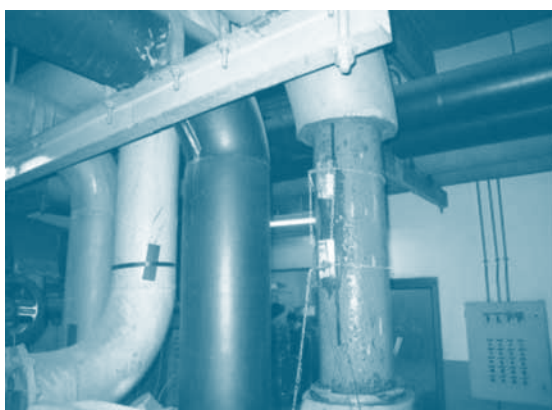
การตรวจวัดอัตราการไหลของน้ำเย็นด้วย Ultrasonic Flow Data Logger
