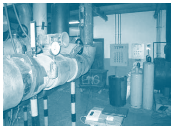
การตรวจวัดอัตราการไหลของน้ำเย็นด้วย Ultrasonic Flow Data Logger
