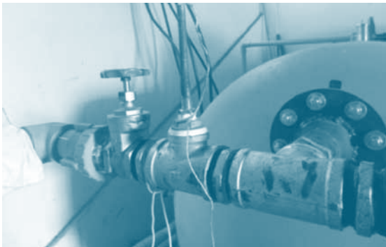
การตรวจวัดกำลังไฟฟ้าของระบบผลิตน้ำร้อนด้วยปั๊มความร้อนหลังการปรับปรุง
