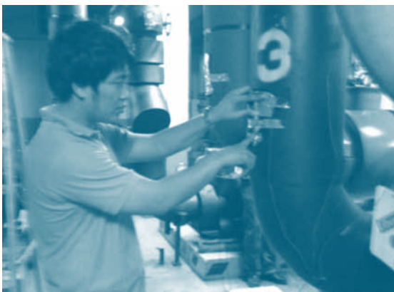
การติดตั้งเครื่องมือในการตรวจวัดและบันทึกค่าอุณหภูมิและความชื้นของอากาศ
