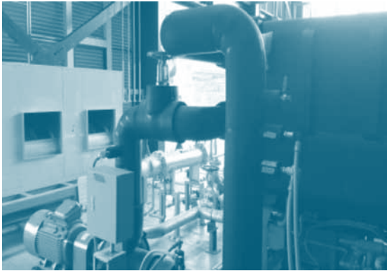
ปั๊มน้ำเย็น (CHP2) และปั๊มน้ำระบายความร้อน (CTP2) ที่ตรวจวัดกำลังไฟฟ้า
