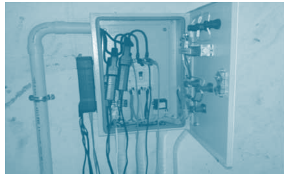
การตรวจวัดกำลังไฟฟ้าของระบบผลิตน้ำร้อนด้วยปั๊มความร้อนหลังการปรับปรุง
