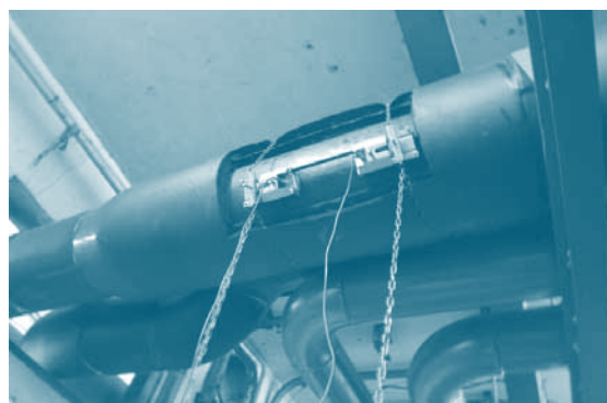
ตำแหน่งติดตั้งเครื่องมือตรวจวัดอัตราการไหลของน้ำแบบ Ultrasonic
