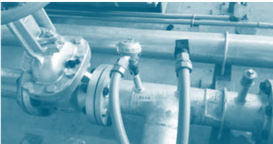
ตำแหน่งตรวจวัดความดันไอน้ำเข้าเครื่องทำความเย็นแบบดูดซึมและอุณหภูมิน้ำคอนเดนเสทขาออก
