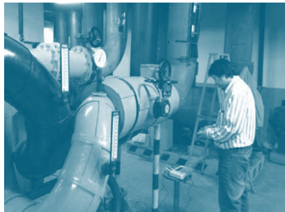
การใช้เครื่องมือในการตรวจวัดอัตราการไหลของน้ำเย็นแบบ Ultrasonic
