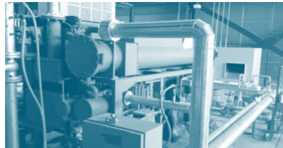
ตำแหน่งตรวจวัดความดันไอน้ำเข้าเครื่องทำความเย็นแบบดูดซึมและอุณหภูมิน้ำคอนเดนเสทขาออก
