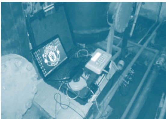
การตรวจวัดอุณหภูมิและอัตราการไหลของน้ำร้อนหลังการปรับปรุง
