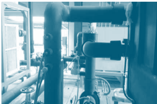
ตำแหน่งตรวจวัดอุณหภูมิน้ำเย็นด้านจ่าย(CHS) และด้านกลับ (CHR)
