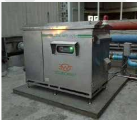
ภาพการดำเนินงานหลังปรับปรุง
