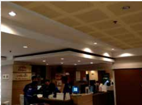
ภาพก่อนปรับปรุง
